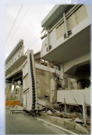
『食満の新幹線高架橋落下現場』 震災当時の写真は 尼崎市立地域研究資料館提供
